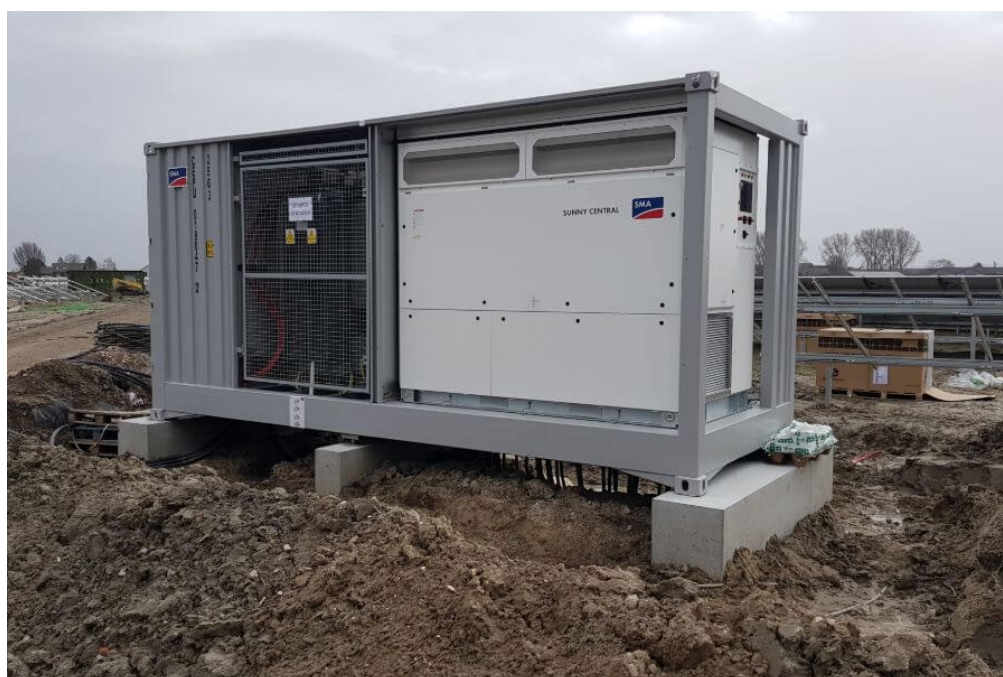
Figura 3: Basamenti Inverter [fonte RNRG]
